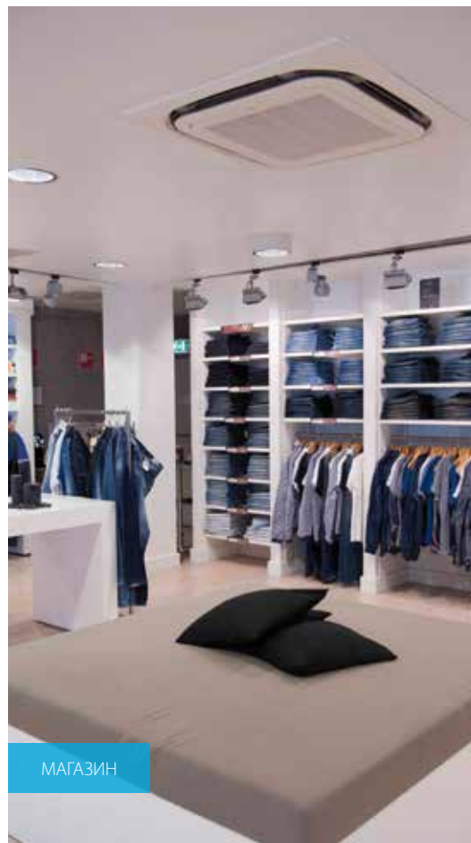
Таванна касета с кръгъл поток FXFQ-A: 360° разпределение на въздушния поток за оптимална ефективност и комфорт
